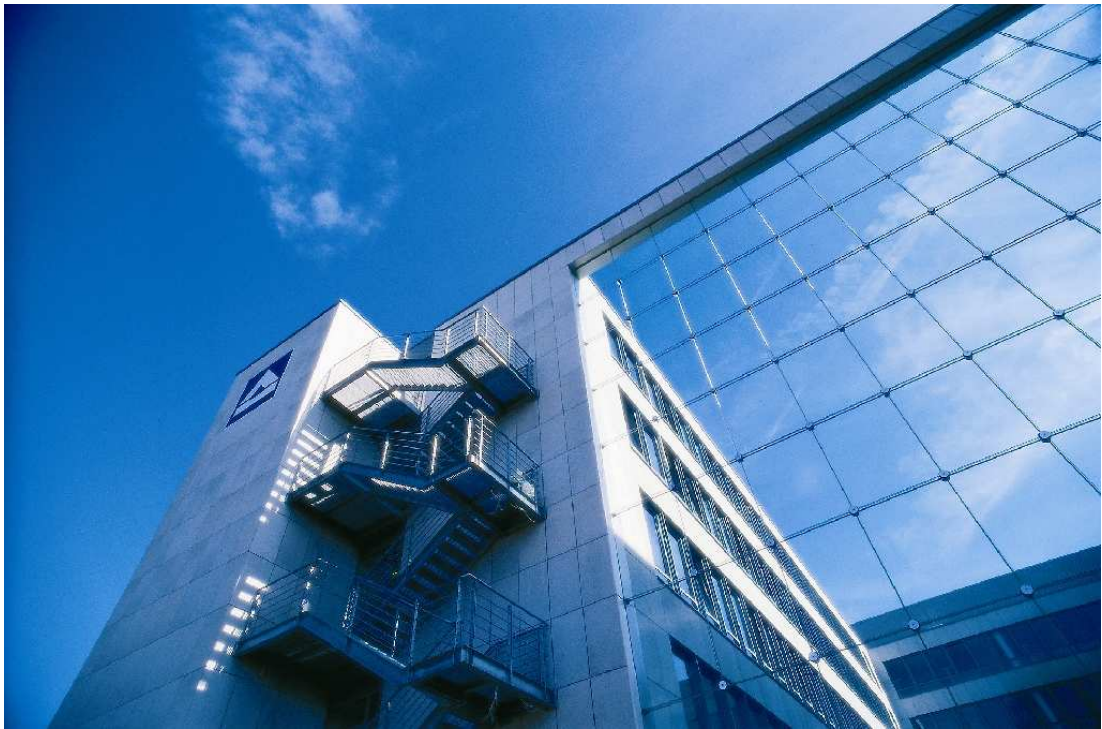
Abbildung 8 Büroпарк an der Gruga, HOCHTIEF
