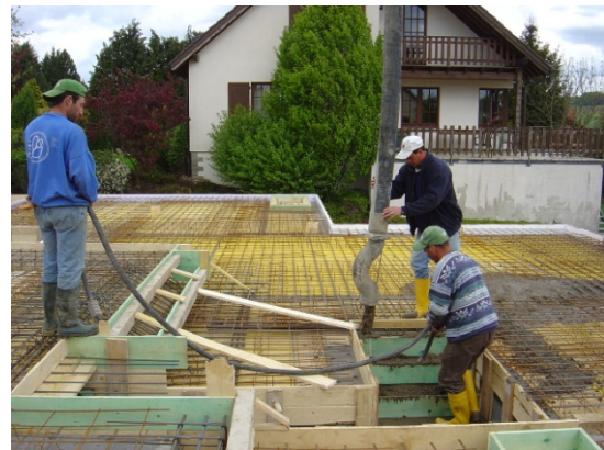
Teamarbeit beim Betonieren
